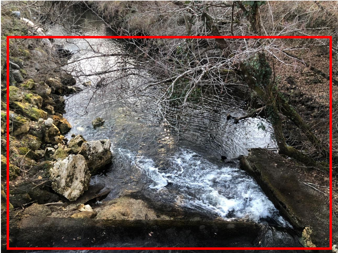
Figure 6. Photographie de l'aval du barrage - Prise du haut du barrage
